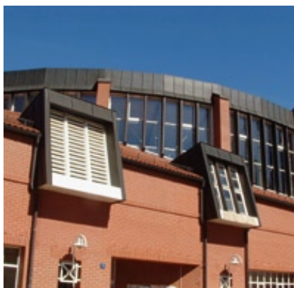
L'installation de ventilation d'un auditoire de l'université à Kassel (Allemagne).
